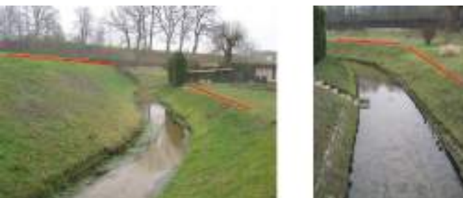
rys. 4 Górna krawędź skarpy interpretowana jako wyraźna krawędź brzegu – źródło RZGW Gliwice
