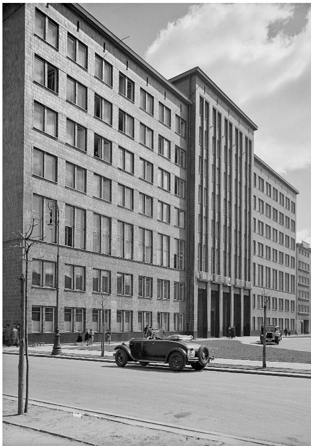
Fotografia 8 Gmach Ministerstwa Robót Publicznych przy ul. Tytusa Chałubińskiego 4/6 w Warszawie.
