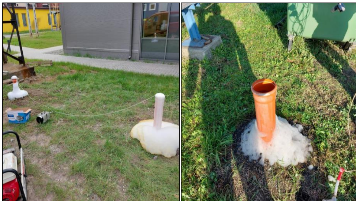
Rysunek 9. Proces napowietrzania otworów aplikacyjnych po iniekcji biopreparatu na terenie poletka zanieczyszczonego substancjami ropopochodnymi
