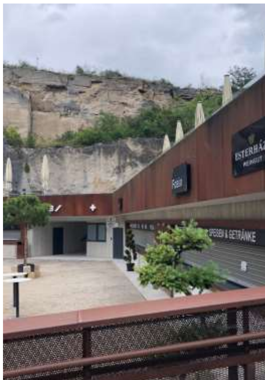
Fot. 27 Wykorzystanie formy wyrobiska do skameralizowania strefy wejściowej; Widok na strefę kas z wnętrza kamieniołomu (Fot. A.Ch.)
