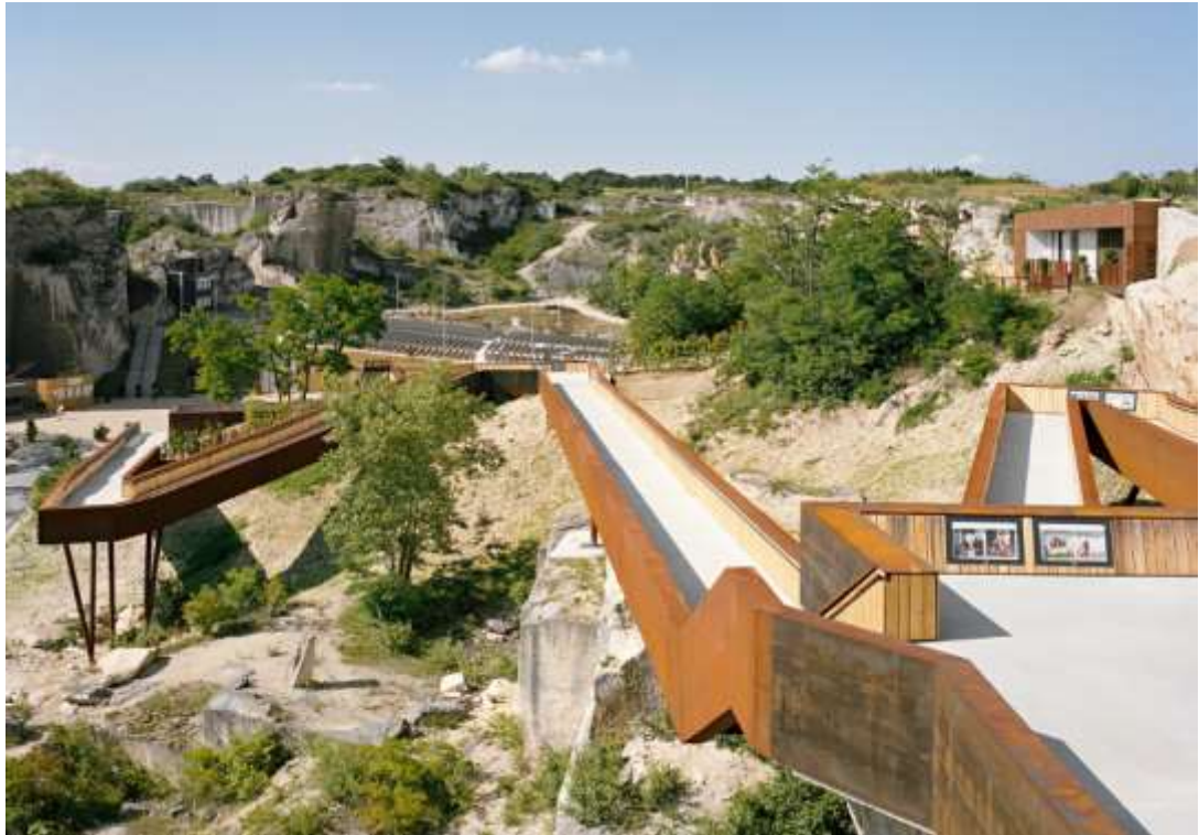
Fot. 28 Przykład działań w zakresie zapewnienia dostępności obiektu, poprzez formę komunikacji pionowej; Widok ze szczytu pochylni w SM (Fot. Hertha Hurnaus za zgodą)
