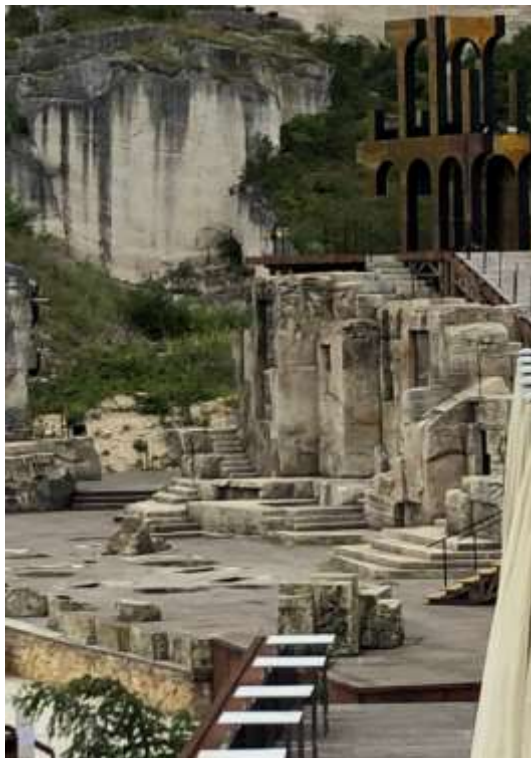
Fot. 9 Przykład sceny operowej w wyrobisku poeksploatacyjnym; Opera Sankt Margarethen, Austria (A.Ch.)
