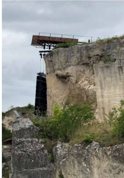
Fot. 31 Wykorzystanie ścian jako elementów podparcia infrastruktury scenicznej (Fot. A.Ch.)
