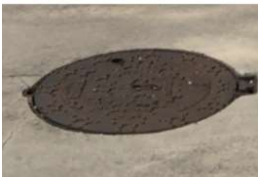
Fot. 32 Punktowe i liniowe odwodnienia pozwala na wychwyt wody opadowej z pochylni (Fot. A.Ch.)
