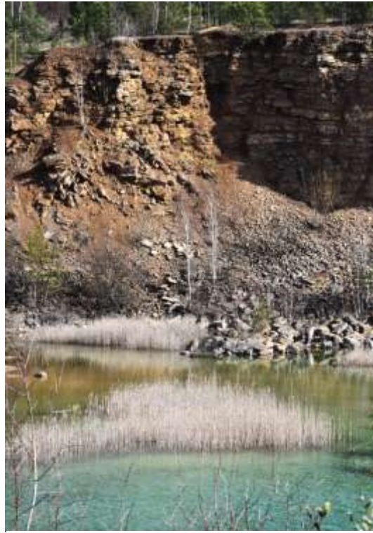
Fot. 69 Degradacja ścian na skutek wietrzenia (Fot. A.Ch.)
