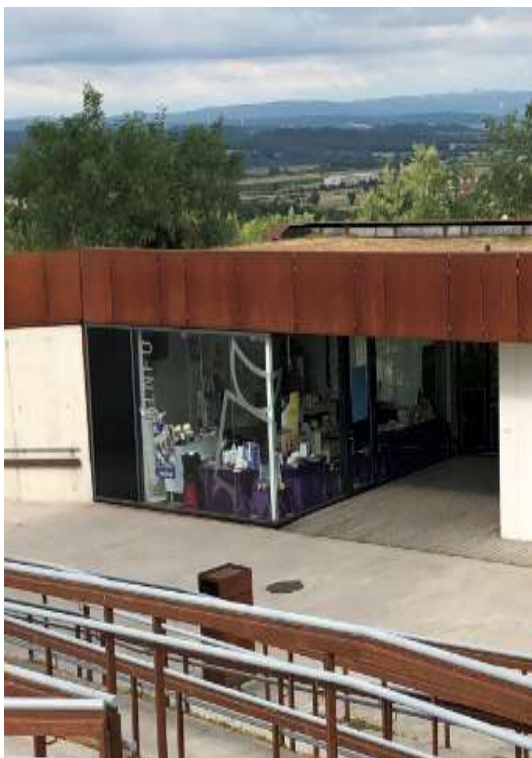
Fot. 26 Wykorzystanie formy wyrobiska do skameralizowania strefy wejściowej; Widok na kasy biletowe z korony wyrobiska (Fot. A.Ch.)
