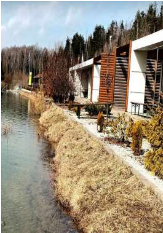
Fot. 60 Stromy brzeg zbiornika determinujący dostępność KG (Fot. A.Ch.)
