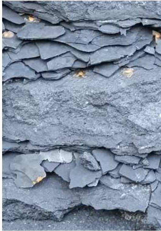
Fot. 53 Naprzemianległe warstwy piaskowców i łupków utworów fliszowych w KK (Fot. A.Ch.)
